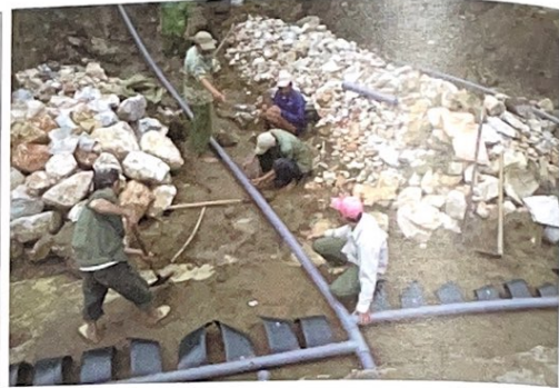
Hình 5: Sơ đồ bố trí hệ thống thu gom nước mái đồi - Công trình hào thu nước mái đồi ở bản Chiềng Chăn 3, xã Chăn mưa, tỉnh Lai Châu.
