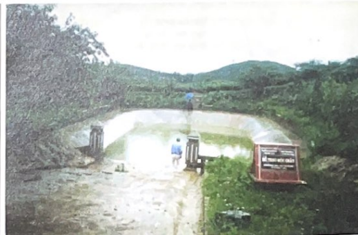
Hình 3: Thiết kế hệ thống thu nước mặt xung quanh hồ - hồ treo Mộc Châu
